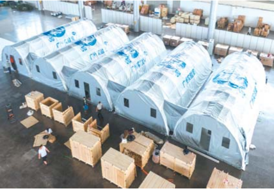
新华社发 8月10日在江苏扬州国际展览中心拍摄的搭建中的“猎鹰号”硬气膜实验室(无人机照片)。8月12日0到24时,扬州新增本土确诊病例25例。截至目前,扬州已累计报告本土确诊病例510例。从54例到37例、25例,近期连续两天确诊人数下降,扬州疫情走势牵动人心。
