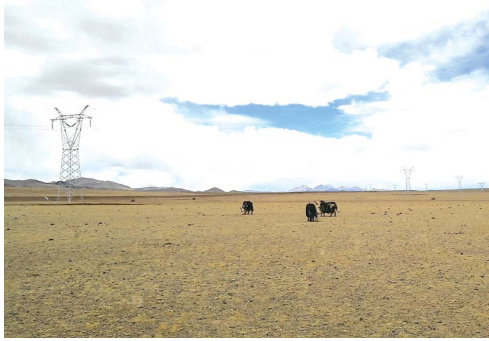
西藏阿里地区改则110千伏输变电工程
