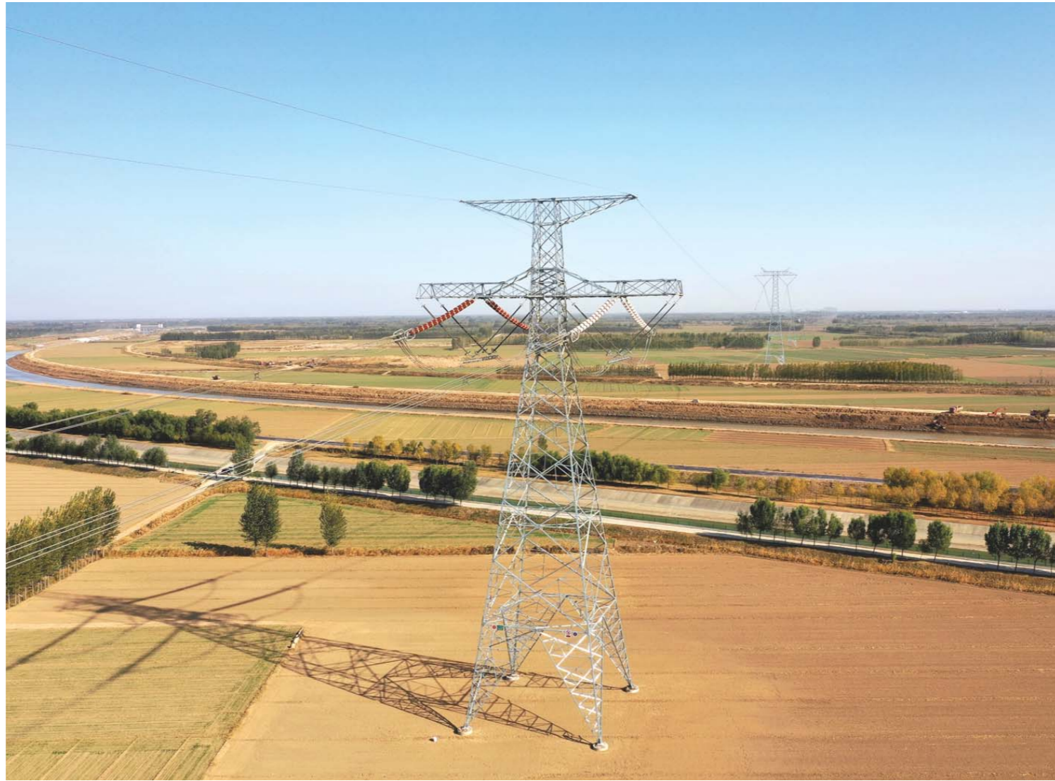
小清河复航全线电力迁改工程
