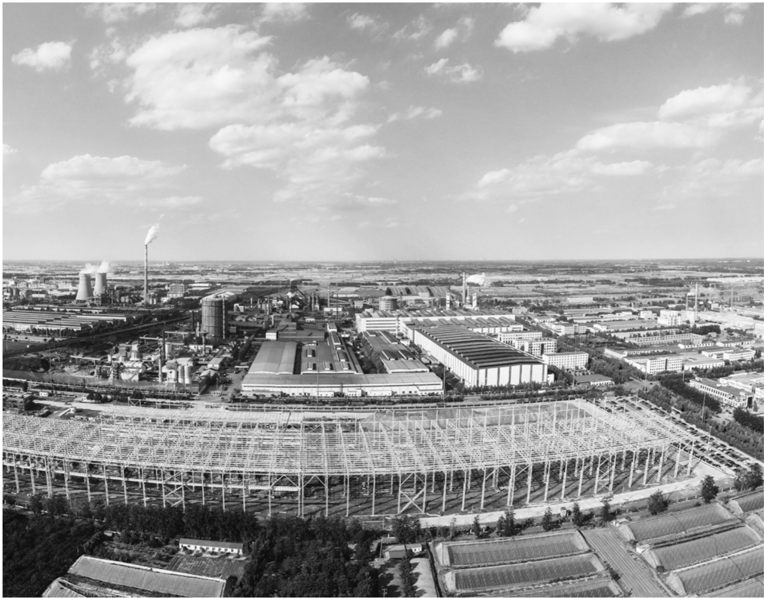
寿光经济技术开发区,巨能特钢高品质特钢精整生产线项目正在加紧施工。
