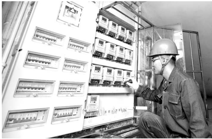
供电公司工作人员在居民小区内进行“一户一表”改造。
