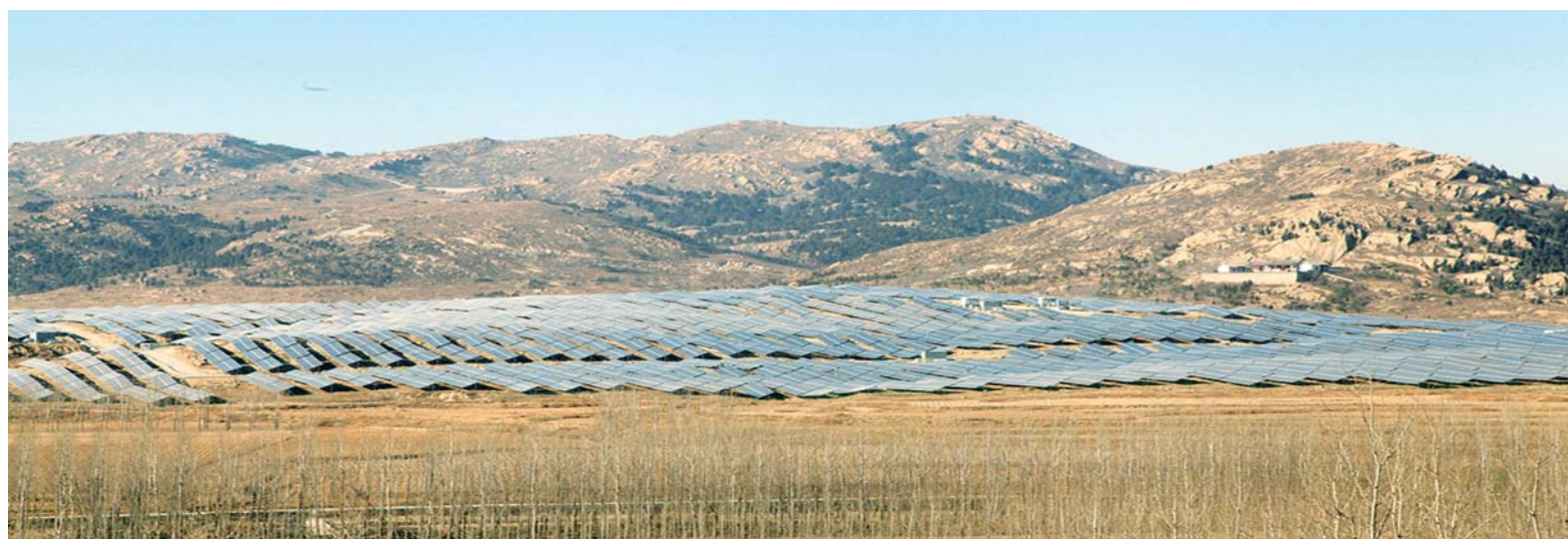
△高峪镇光伏发电项目
