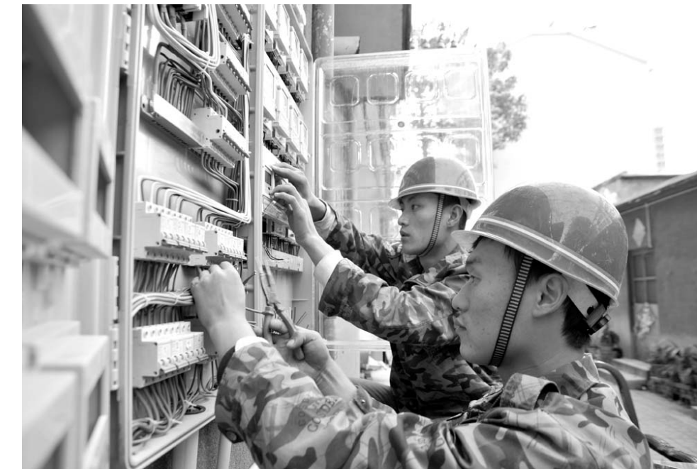
“一户一表”工程改造现场。
