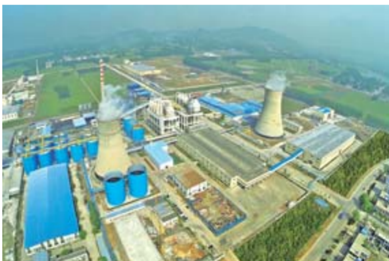
△现代盐化工业园区一角
