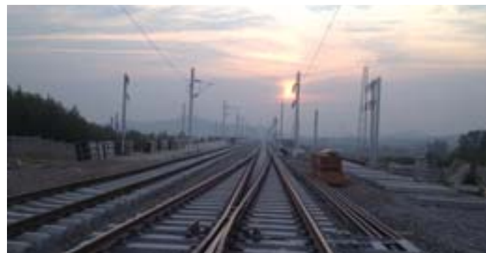
△完成铺轨的青荣城铁路
