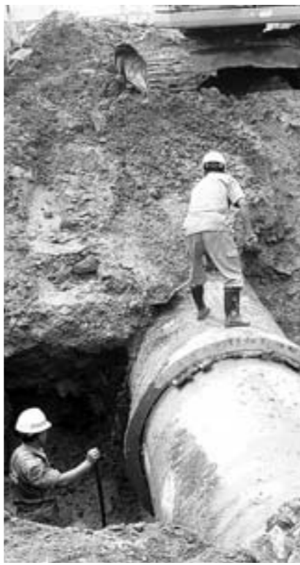
□大众报记者 梁开文 报道 10日上午,工作人员正在紧张抢修。
