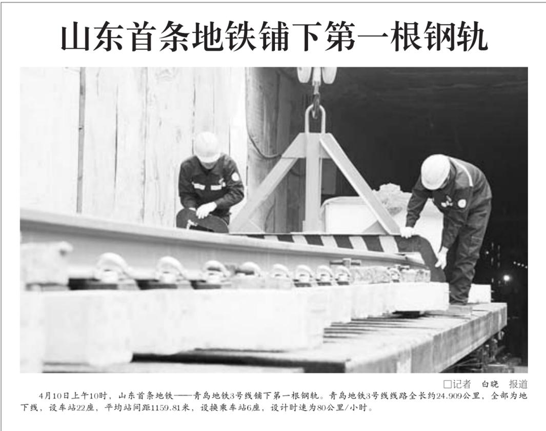
4月10日上午10时，山东首条地铁——青岛地铁3号线铺下第一根钢轨。青岛地铁3号线线路全长约24.909公里，全部为地下线，设车站22座，平均站间距1159.81米，设换乘车站6座，设计时速为80公里/小时。
