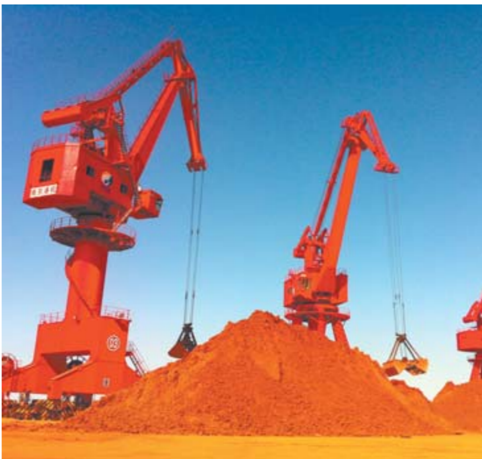
▲投入运营的寿光港泊位。
