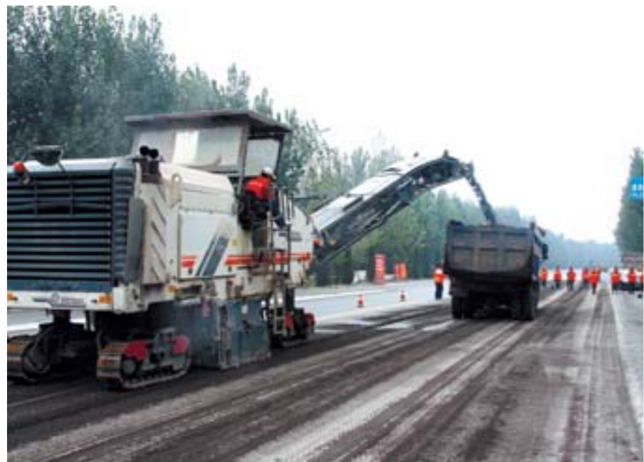
羊田路施工现场。
