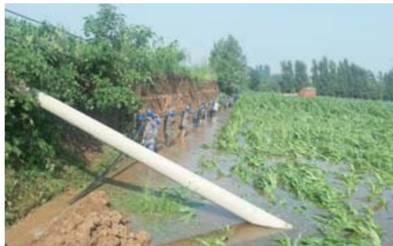
△成功应对迎峰度夏高温、飚线风等极端恶劣天气，全力抢修受损线路。
