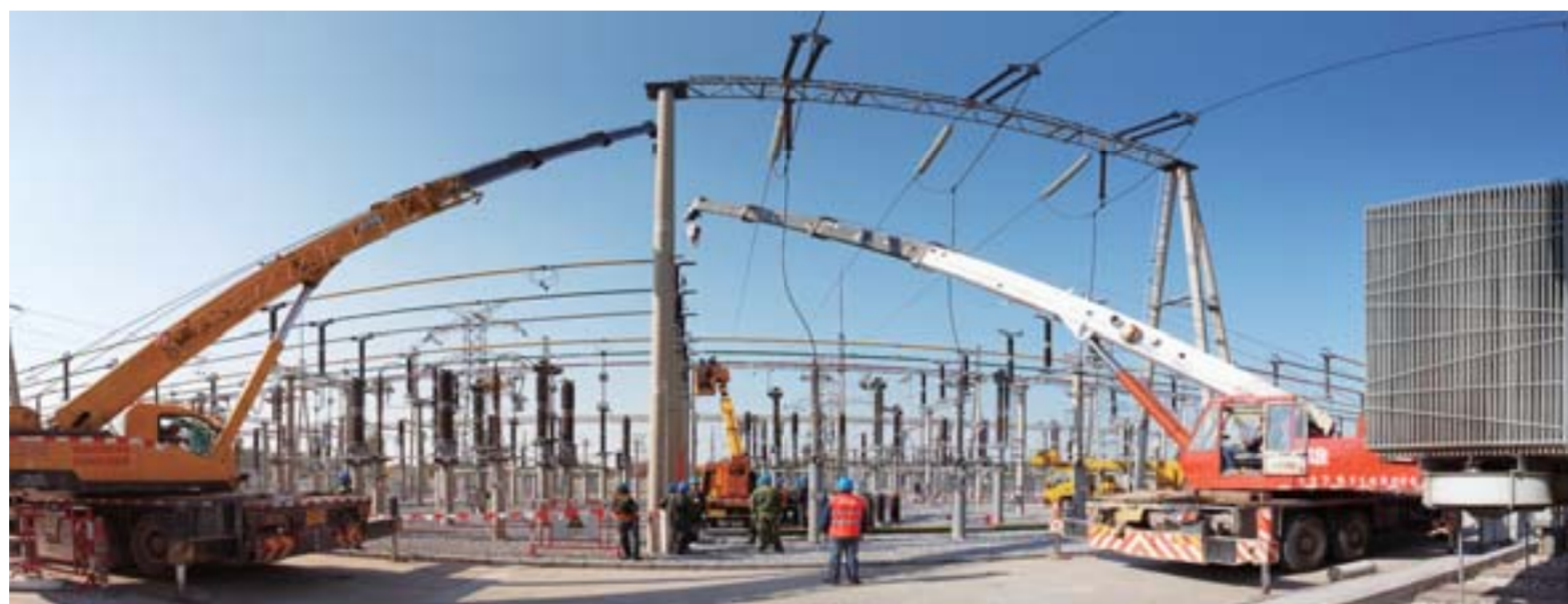
△2013年11月18日，许寺变电站改造工程顺利竣工，为济南西部地区经济发展和居民生活提供可靠电力供应。
