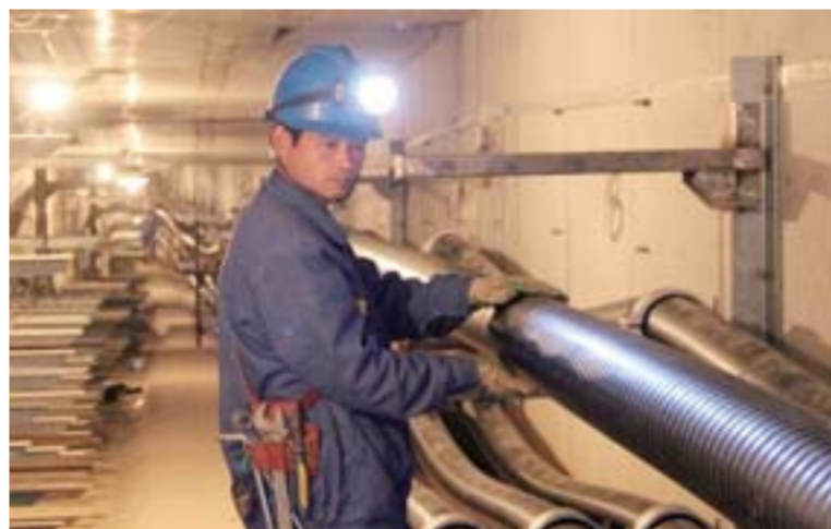
△实施东部城区220KV高压线路落地工程，在省内电缆截面最大、距离最长。
