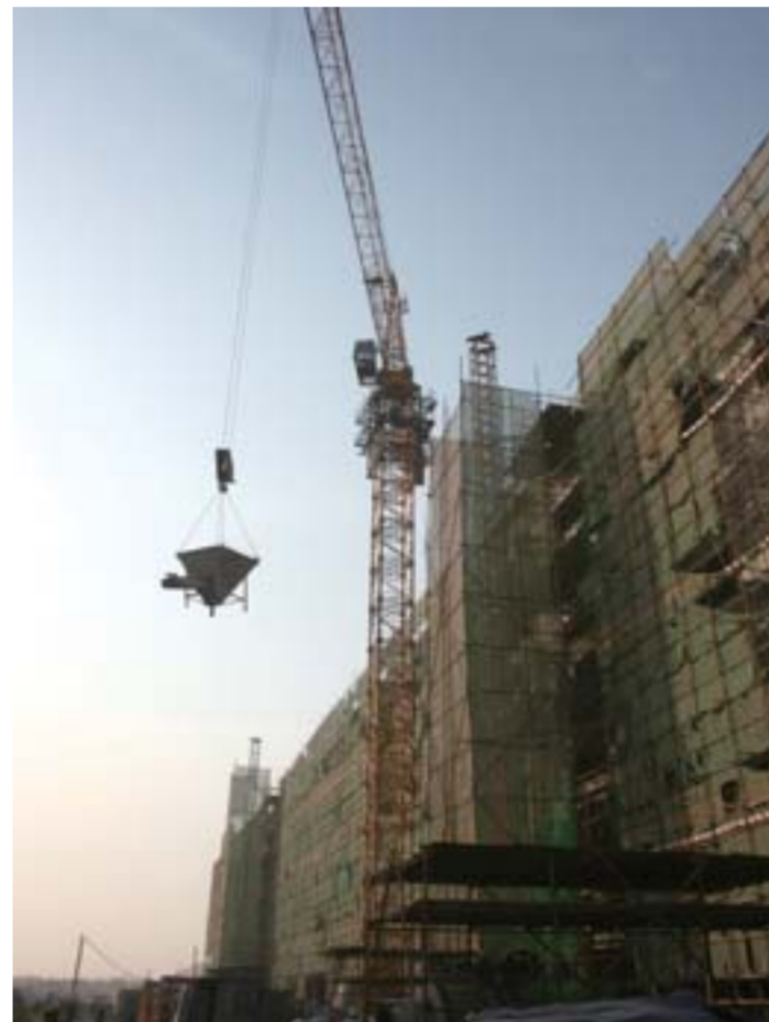
△“北跨”施工现场
