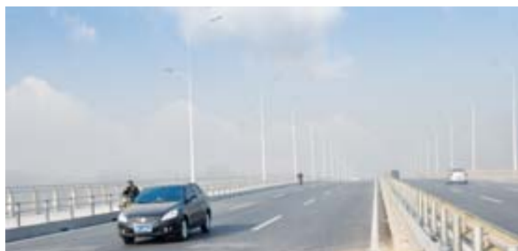
△泗河九州大桥
