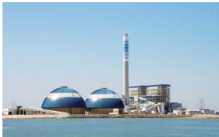
△清洁幽静的华电莱州电厂
