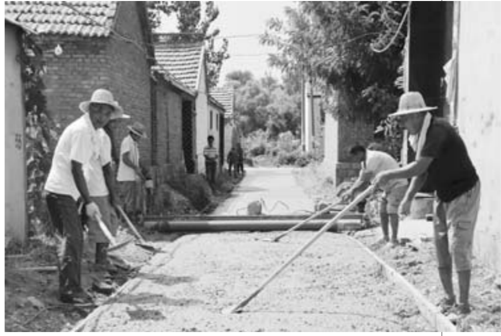
□丁运杰 报道 鱼台县张黄镇大冈村“户户通”工程施工现场。(资料片)
