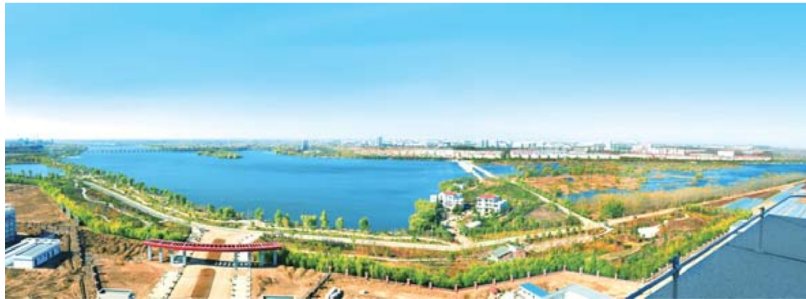
△建设中的大汶河沿岸景观带
