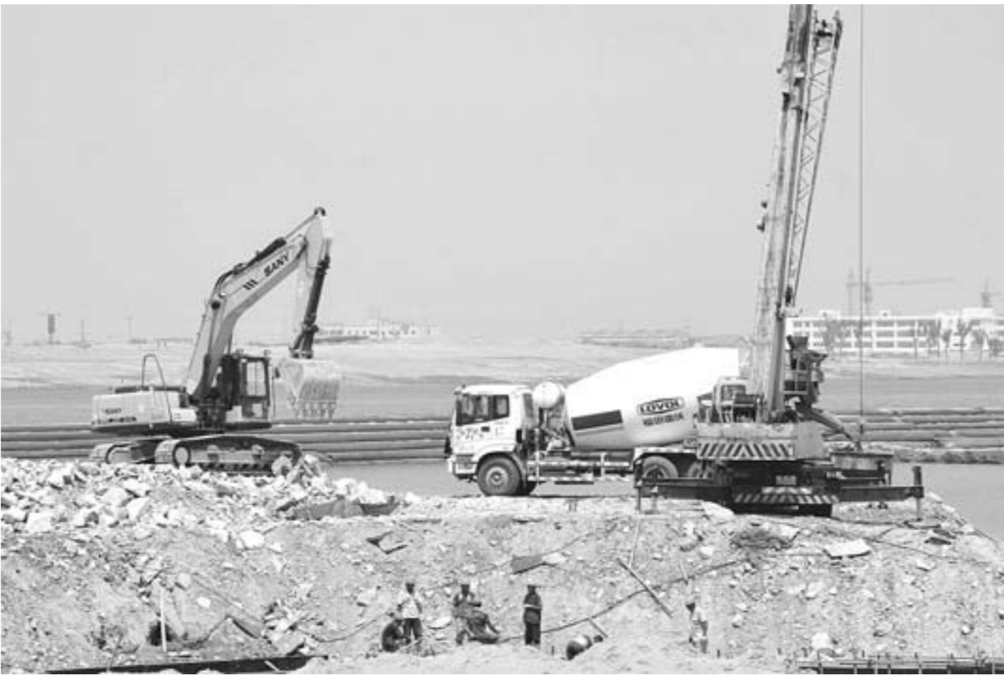
□记者 王佳声 见习记者 宋昊阳 报道 潍坊市滨海开发区加大对白浪河进行综合整治和提升力度。以白浪河为生态景观轴线，打造蓝海水岸分区、流水商业街、沙滩主题文化公园等6个功能区。沿河规划建设游艇码头、内河沙滩和城市综合体。图为白浪河入海口生态示范带驳岸建设现场。
