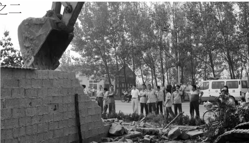
▲路域环境综合整治拆除现场。
