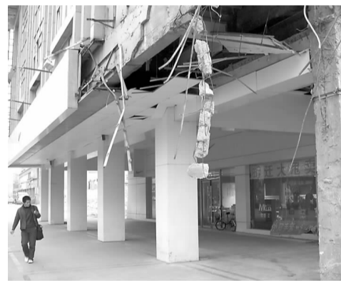
昨日,舜井街与泉城路交界处,大批建筑物正在被拆除,一些水泥块摇摇欲坠,行人们在没有防护的路上行走感觉有点悬。
