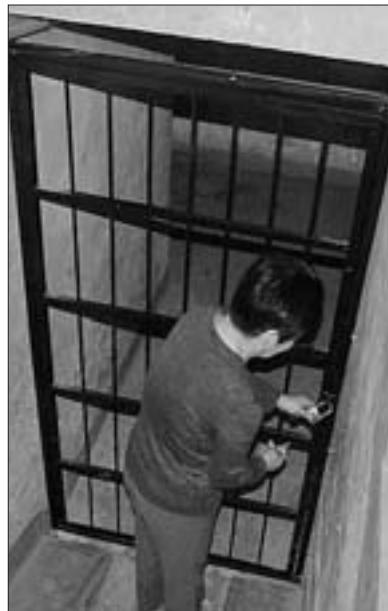
▲地下室的铁门。
