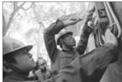
▲电力工作人员加班加点为小区安装设备。 戴伟 摄
