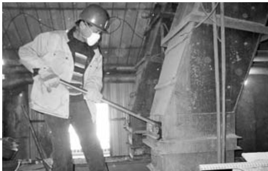
►东新热电厂的工作人员疏通锅炉的下煤筒。
