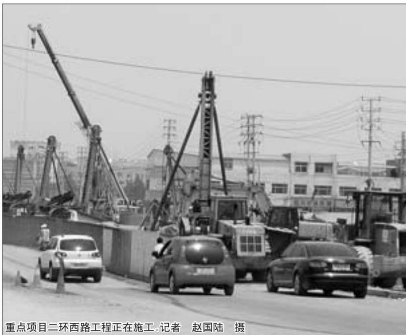
重点项目二环西路工程正在施工。记者 赵国陆 摄
