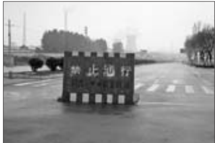
奥体西路与涵源大街交叉口,立着一块“禁止通行”的牌子。
