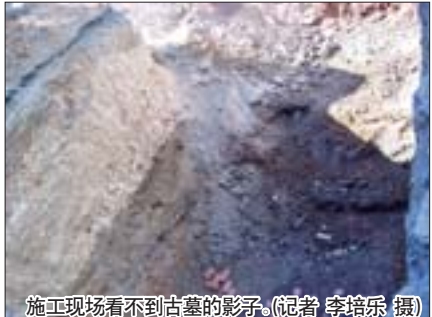
施工现场看不到古墓的影子。(记者 李培乐 摄)
