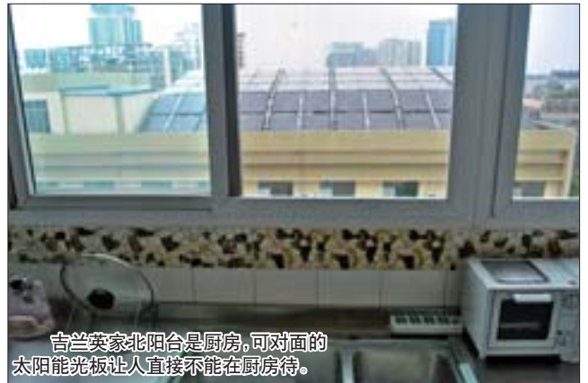
酒店楼顶的太阳能光板。
