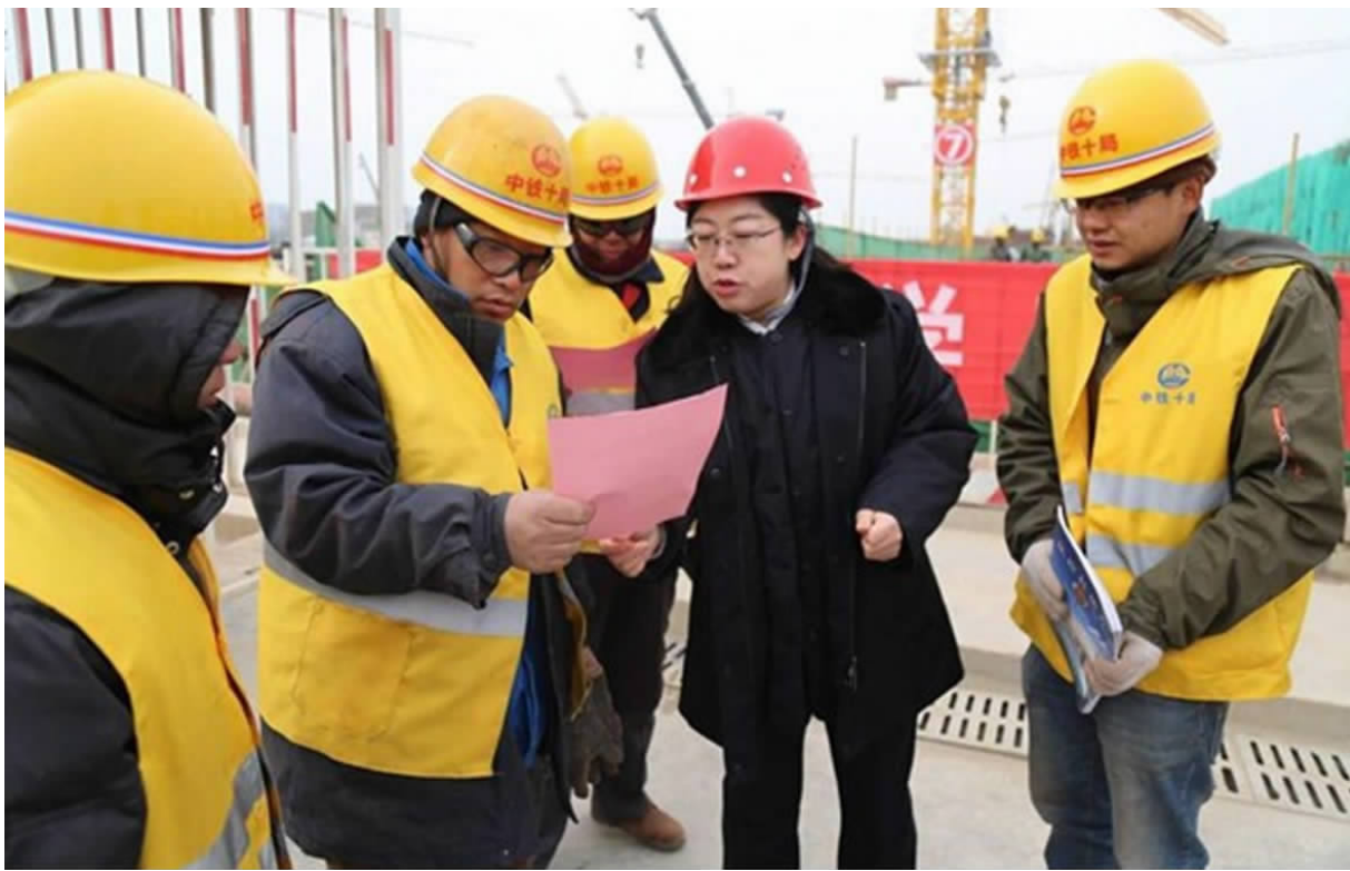
近日，济南铁路检察院巡回检察室中铁十局工作站深入济南新东站项目部工地现场，开展了以“切实保障民生维护农民工合法权益”为主题的检企共建座谈会。干警深入工地现场，发放宣传资料和便民联系卡，针对农民工普遍关注的劳动合同签订、工资发放、工伤赔偿、劳动保护和医疗保障等问题提供法律咨询服务，耐心讲解与用人单位发生劳动争议时多元化维权途径，引导劳动者合理合法有效地表达诉求。座谈会上，与项目部各类工程人员进行交流，深入了解新东站项目建设进展、资金使用、农民工工资发放和环境保护措施等情况，并就避免和处理建设过程中的纠纷等法律问题提出建议。 铁检宣 摄
