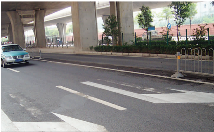
BRT公交车道8米护栏被撞坏。 刘建滨 摄
