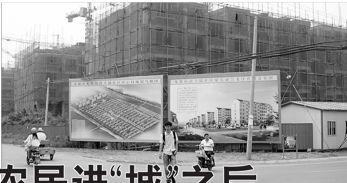
▲正在建设中的诸城市土墙社区。
