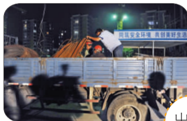
▲赶到施工现场。
