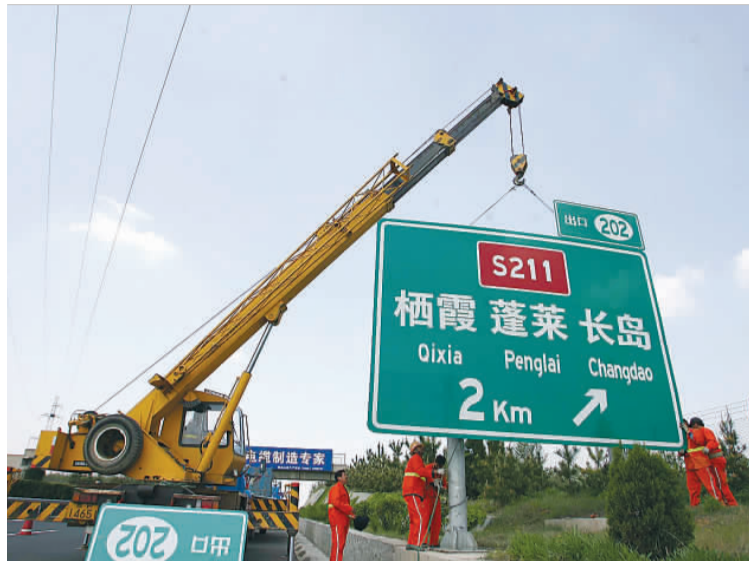
工作人员正在安装新标牌。 本报记者 赵金阳 摄
