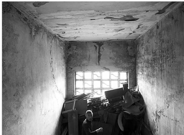
顶层的墙皮已被雨水泡得面目全非。
