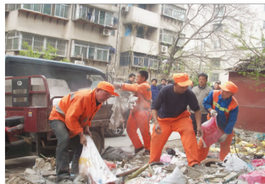
19日,王官庄小区绿地养鸡场拆除。 记者 喻雯 摄
