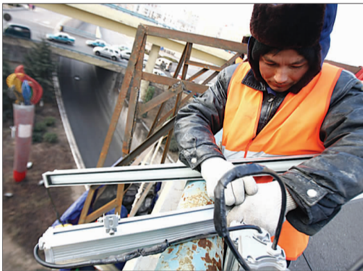
▲工人正在海信立交上安装亮化设施。 杨宁 摄
