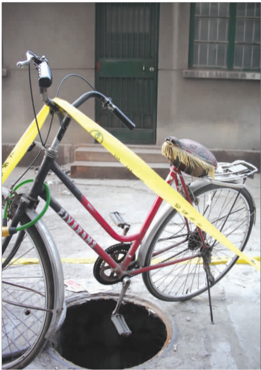
出事的房屋和门前掀起盖子的污水井。 赵丽 摄
