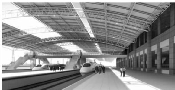
无站台柱风雨棚。(效果图)
