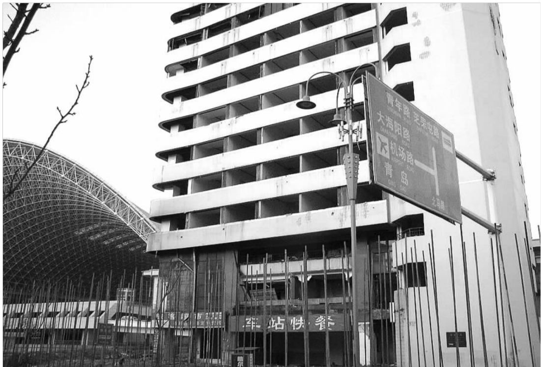
铁道大厦下层玻璃已被拆除。本报记者 任昌浩 摄
