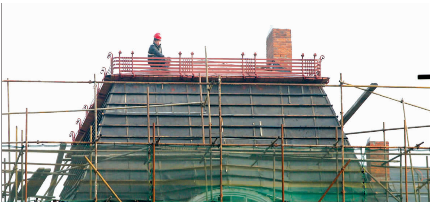
26日，在原青岛胶澳总督府，工人正在屋顶施工。 本报记者 杨宁 摄
