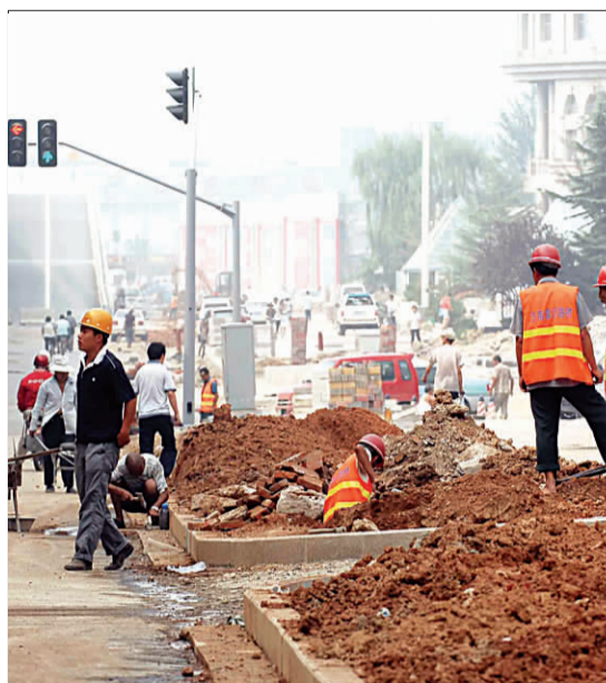
工人们在加班赶工期。记者 邱志强 摄
