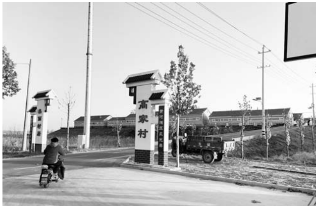
北宋镇高家村改造提升后的村台。
