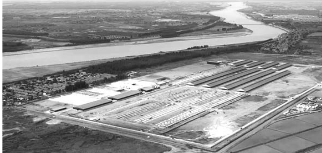
俯瞰黄河岸边董集镇正在建设中的华澳大地牛奶小镇项目。(资料图)
