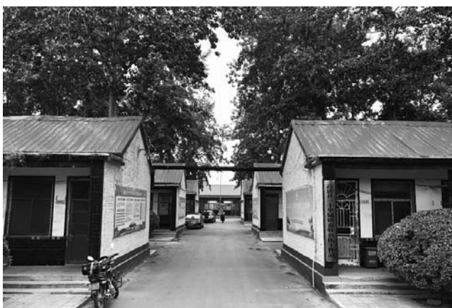
图为建于20世纪90年代初的高唐县三十里铺镇政府大院。8月上旬, 镇政府办公室房顶上盖上了红色铁皮, 漏雨问题已解决。
