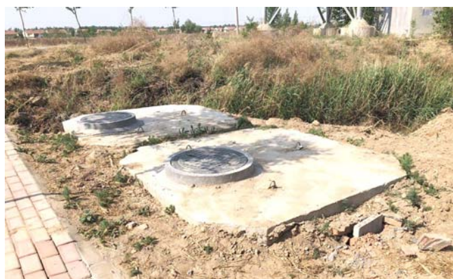
△垦利街道邵家村的2个污水收集池。该区有82个村庄采取这种模式收集处理污水。
