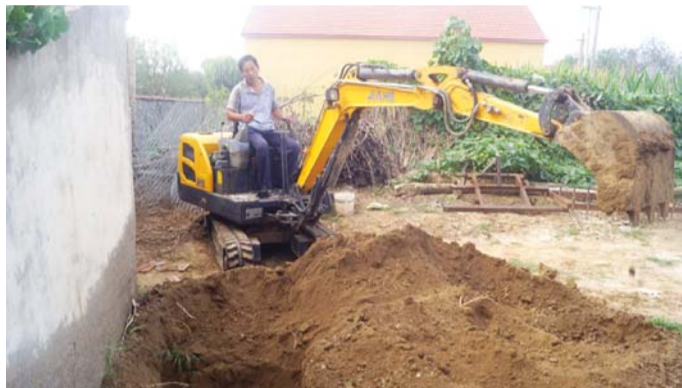
▲ 挖掘机在李丙兰家施工。
