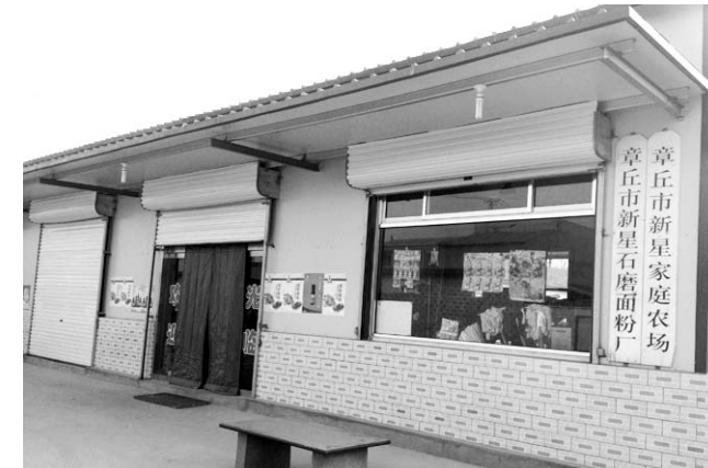
▲闫码村在村委旧址上建起了面粉厂和超市。
