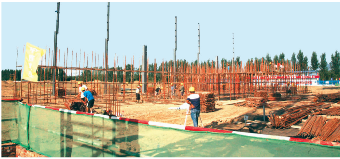
该项目是北汽集团落地滨州的首个项目。图为项目加工中心建设现场
