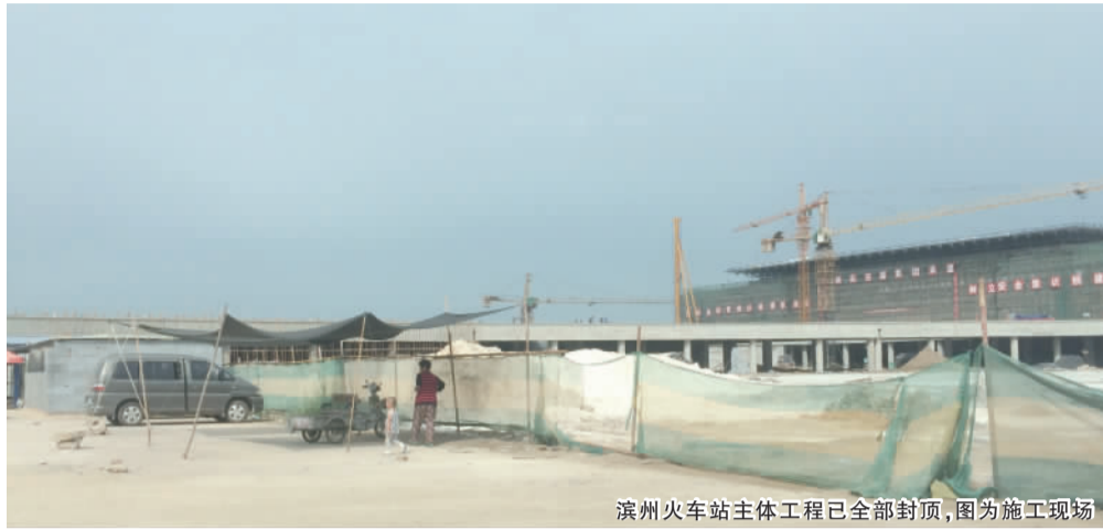
滨州火车站主体工程已全部封顶,图为施工现场
