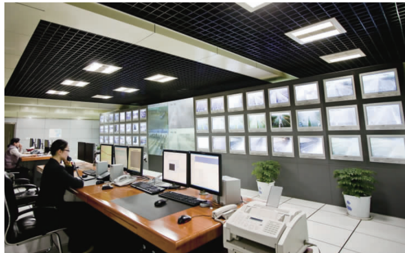
山东联通为山东高速建设的智能交通系统,做到了实时监控道路状况,确保安全畅通。
